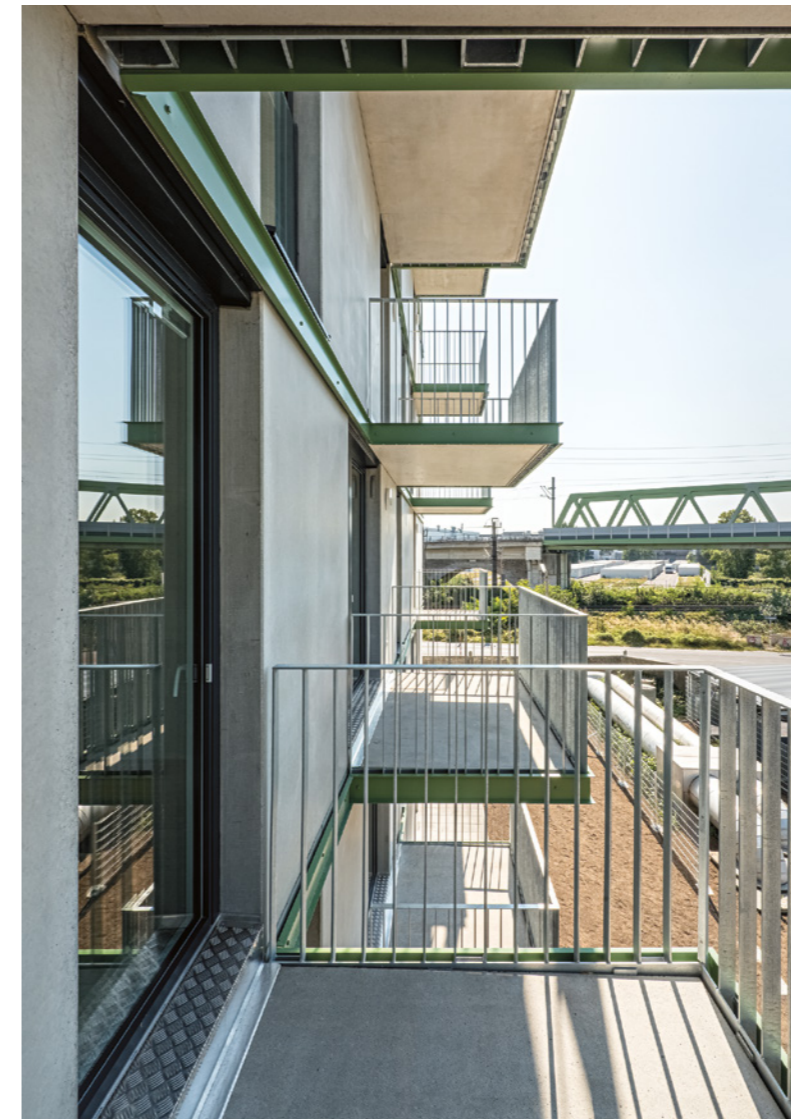
Blick von einem Balkon: Die umlaufenden Stahlelemente spielen auf die Materialität der Eisenbahnbrücke im Hintergrund an.
